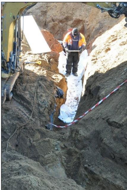
Runkohuoneen pohjoispuolen viemärikaivannon itä–länsi-suuntainen osa lopullisessa syvyydessään. Itäkoillis-
