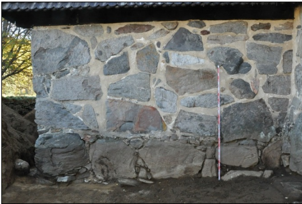
Sakastin länsiseinä alaosa esille puhdistettuna. Länsilounaasta.
