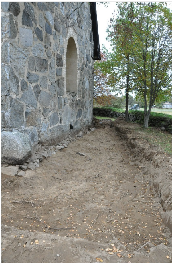
Kirkon itäpäädyn bentoniittimattoalue lopulliseen syvyyteensä kaivettuna. Kaakosta.
