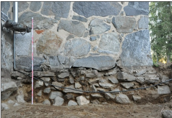
Asehuoneen länsiseinän alaosa esille puhdistettuna. Länsilounaasta.
